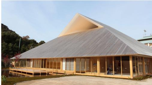
仕様：敷地面積 3,096m<sup>2</sup>、建築面積 1,269m<sup>2</sup>、延床面積 1,272m<sup>2</sup>、階数 地上1階、構造 鉄骨造（一部鉄筋コンクリート造、木造）
